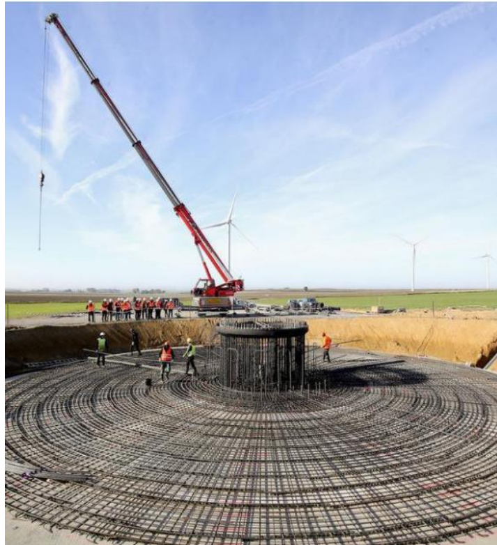
Figure 18 : Visite de chantier du parc éolien de Chemin de Valenciennes (commune d'Haussy - Nord), du 11 octobre 2022
